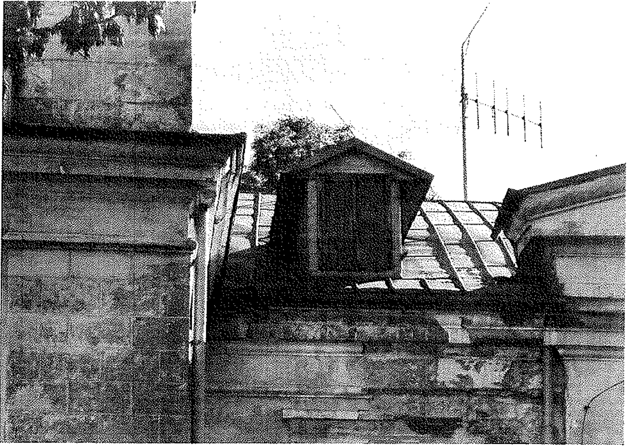
Il. 2. Mianocice. Dom Pomocy Społecznej. Budynek datowany na XVIII w. Stan zachowania przed rozpoczęciem prac remontowo-konserwatorskich w części dachu. Ukazany fragment zadaszenia od strony północnej przedstawia silną deformację połaci dachu, jego zanieczyszczenie mikroorganizmami i nieczystościami. Ponadto można dostrzec niewłaściwy sposób funkcjonowania rynien odprowadzających wodę opadową, która wraz z upływem czasu stała się głównym powodem uszkodzenia wypraw tynkarskich w części gzymsu, ścian i okien umieszczonych bezpośrednio pod nią. Na uwagę zwraca również snycerka okienna lukarny, która uległa spłowieniu, porażeniu słonecznemu oraz posiada wiele nieszczelności w szwej obecnej budowie.
