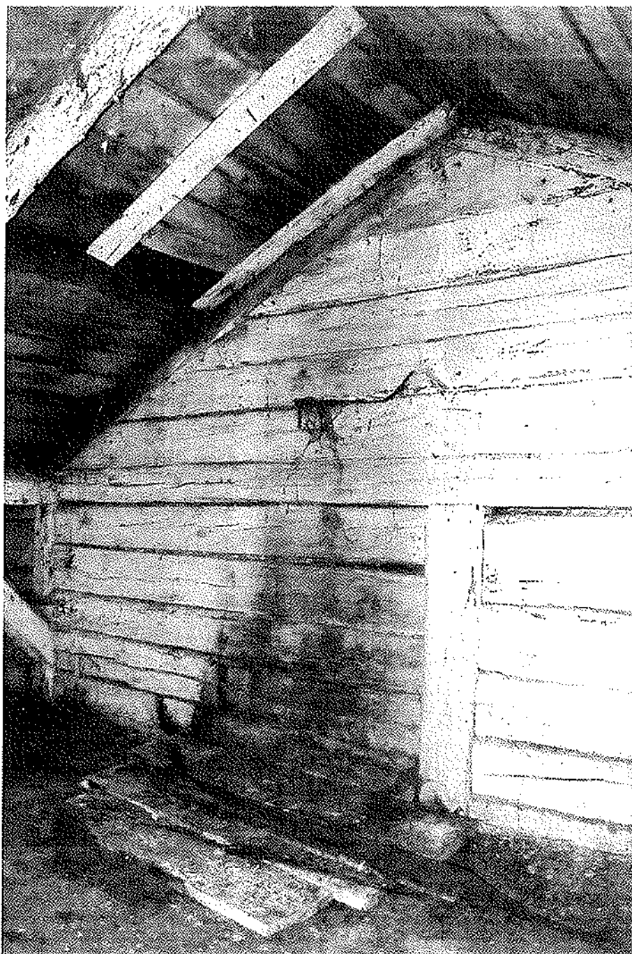
Il. 13. Mianocice. Dom Pomocy Społecznej. Budynek datowany na XVIII w. Stan zachowania przed rozpoczęciem prac remontowo-konserwatorskich w części dachu. Widok na ścianę szczytową dobudowanej części wschodniej. Duża nieszczelność powstała w dachu doprowadziła lub w dalszym ciągu doprowadza do zalewania tej części budynku.
