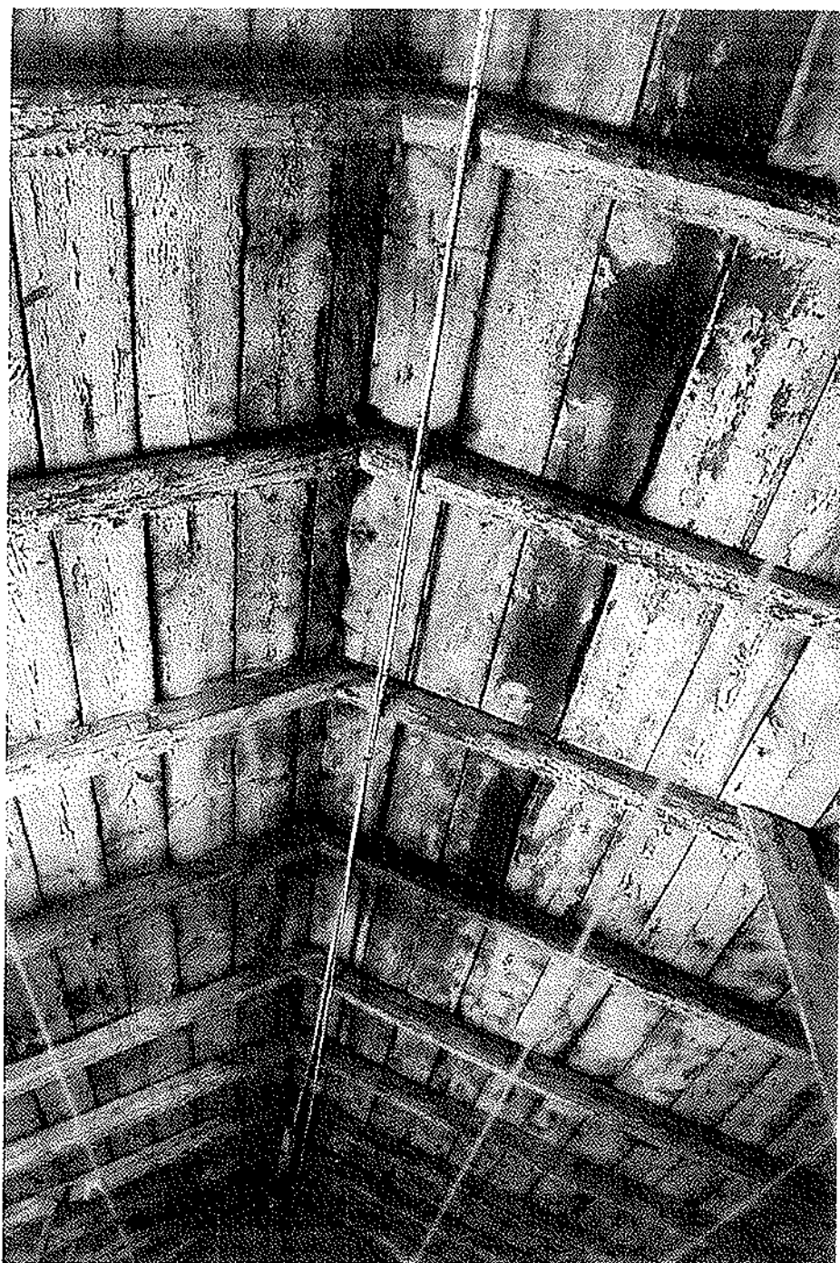
Il. 11. Mianocice, Dom Pomocy Społecznej. Budynek datowany na XVIII w. Stan zachowania przed rozpoczęciem prac remontowo-konserwatorskich w części dachu. Duża powierzchnia poddasza wykorzystuje się w celu min. suszenia wszelkiego rodzaju odzieży i pościeli. Niestety brak odpowiednich otworów wentylacyjnych oraz wysoka temperatura w okresie wiosenno-letnim doprowadza do zawilgocenia dachu od jej wewnętrznej strony. Prowadzi to do rozwoju mikroorganizmów, które także wpływają na osłabienie jakości technicznej zarówno deskowania jak i krokwi.
