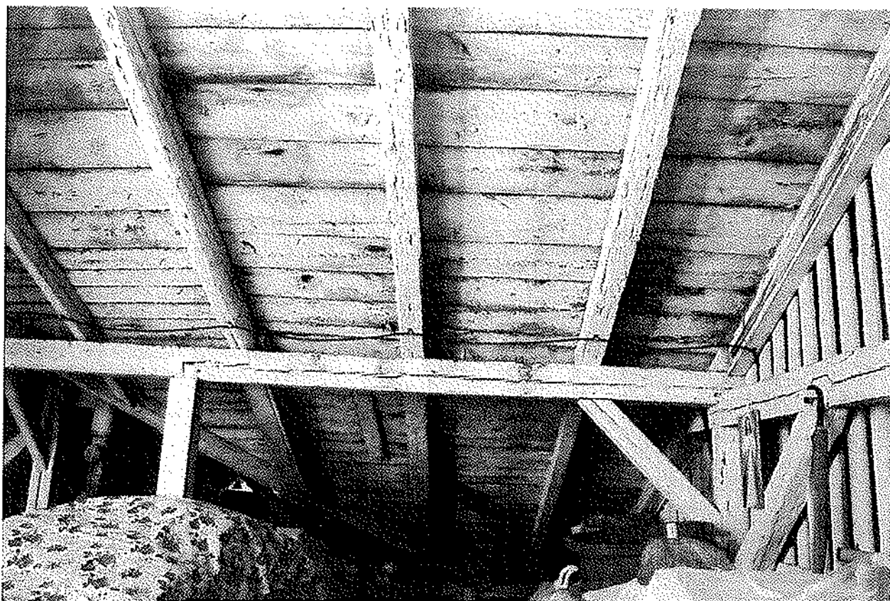
Il. 7. Mianocice. Dom Pomocy Społecznej. Budynek datowany na XVIII w. Stan zachowania przed rozpoczęciem prac remontowo-konserwatorskich w części dachu. Zdjęcie ukazuje kolejny przykład nieszczelności dachu objawiające się powstawaniem zacieków o odcieniu rdzawego brązu.
