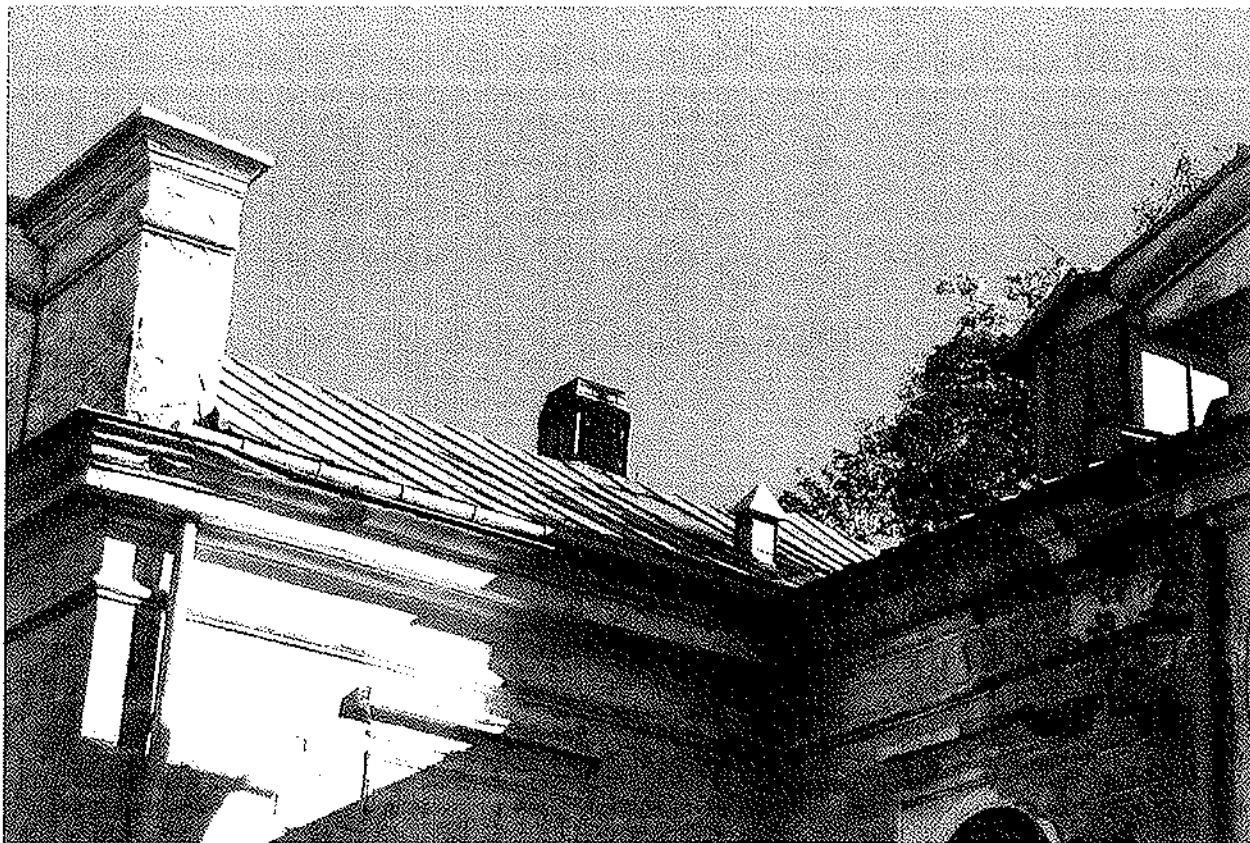
Il. 3. Mianocice. Dom Pomocy Społecznej. Budynek datowany na XVIII w. Stan zachowania przed rozpoczęciem prac remontowo-konserwatorskich w części dachu. Ukazany komin jak widać posiada sine zanieczyszczenie sadzą, która osiada na powierzchni blachy wpływając na jego przyspieszenie jej korozji.
